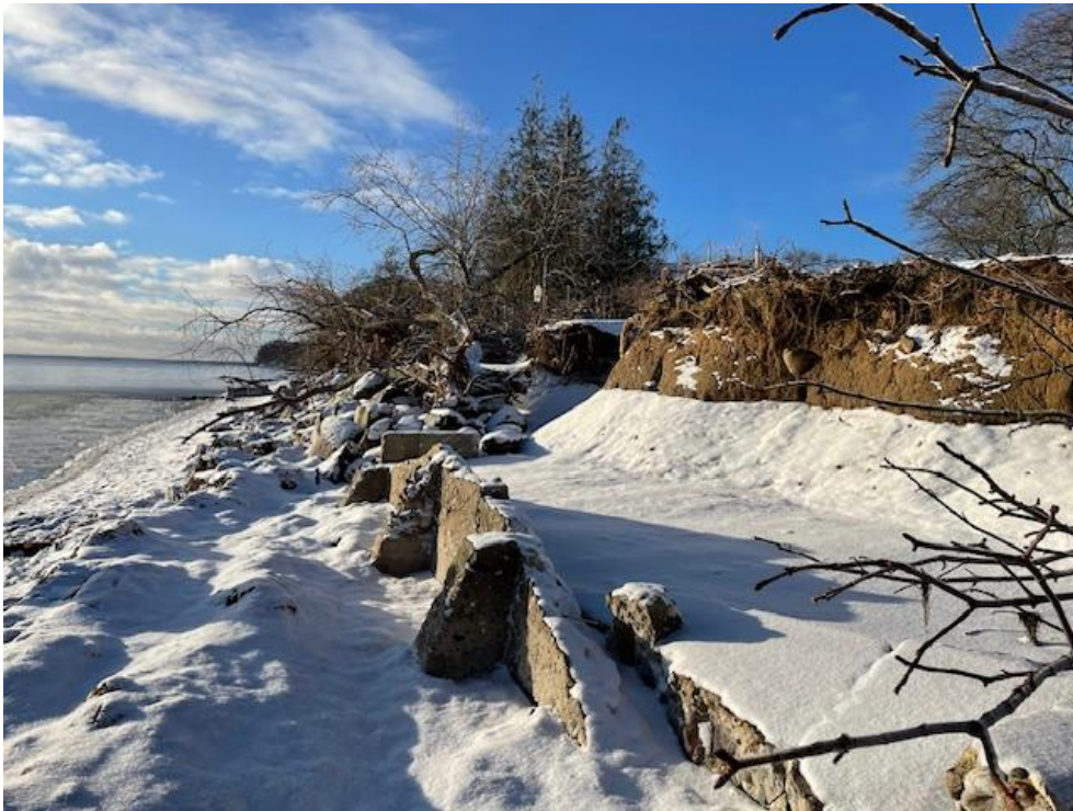
Figur 2-8 Hovedbygningen med lav betonmur, stenkastning og lav betonmur. Nr 1. ses helt til højre med stenkastning og bevoksning over stenkastningen af hybenroser. (foto fra Efterskolens hjemmeside)
