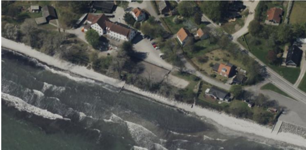
Figur 2-6 Skråfoto set fra havet med nr.1 til højre, og Efterskolens store hovedbygning.
