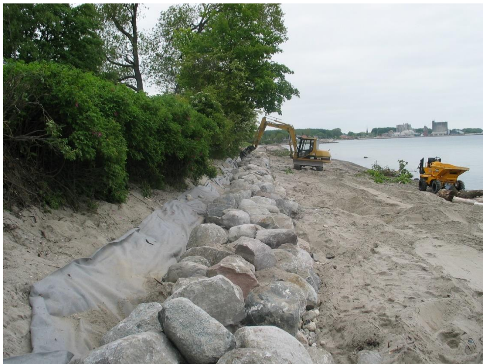
Figur 2-2 Stenkastningen under anlæg
