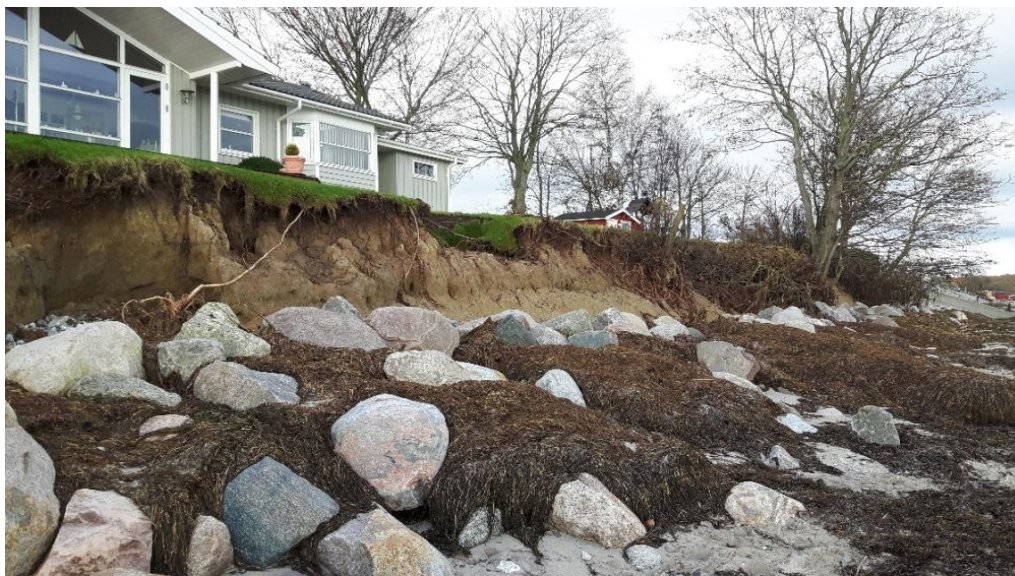
Figur 2-4 Situationen udfor matriklen Strandstræde 1 umiddelbart efter stormfloden. Stenkastningen er udjævnet, og der er sket stor erosion i skrænten over stenkastningen; som var for lav og som blev overskyldet af bølger under højvandet.
