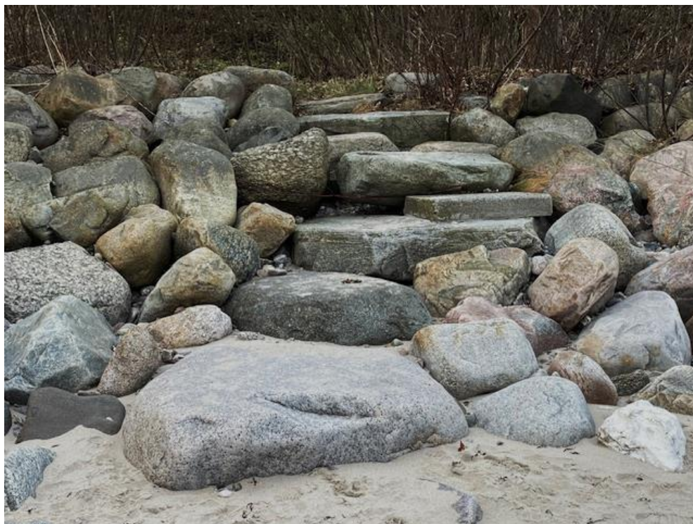
Figur 4-7 Eksempel på smal stentrappe af flade sten i skræntfodssikring (OJJ 2023 Hellebæk Strand)
