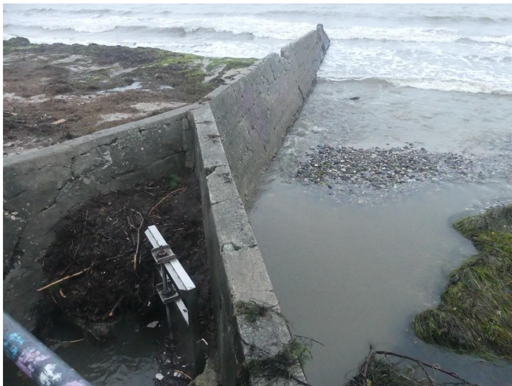
Figur 6-1 Højvandslukke ved udløbet af Krusebækken (foto JK 19.11.2023)
