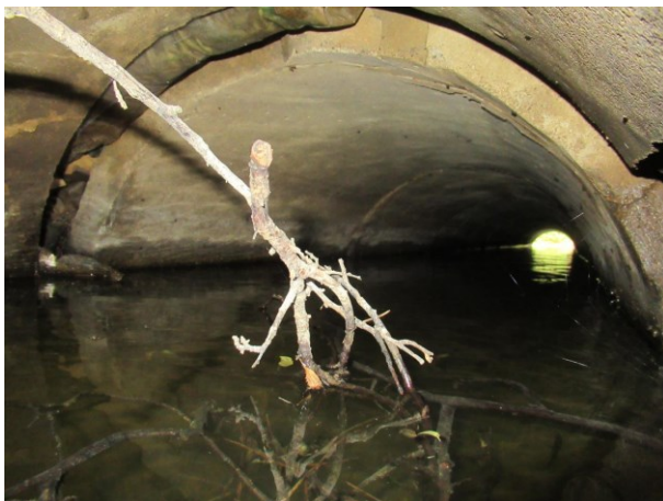
3. Rørunderføring set fra øst mod vest.
