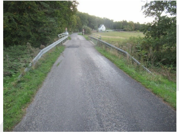
2. Overført vej set mod øst
