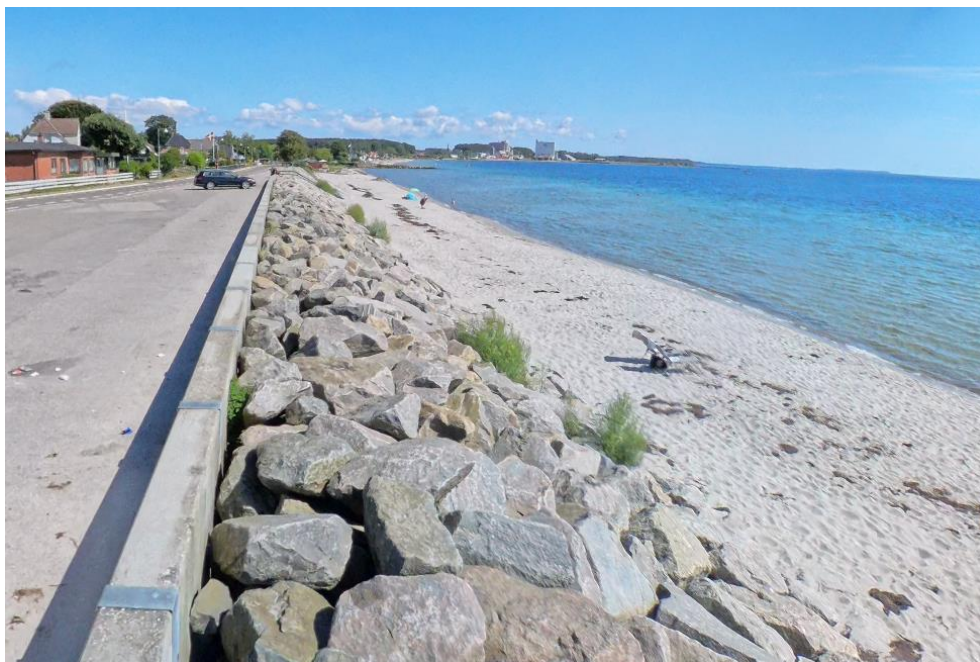
Figur 3-7 Eksempel på højvandsmur med en foranliggende, fungerende skråningsbeskyttelse langs Strandvejen
