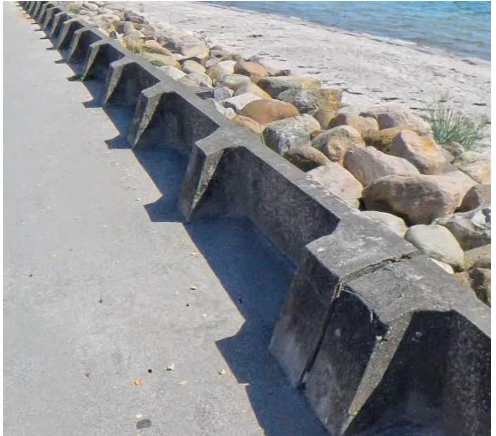
Figur 3-9 Eksempel på højvandsmur langs den nordligste del af strækningen
