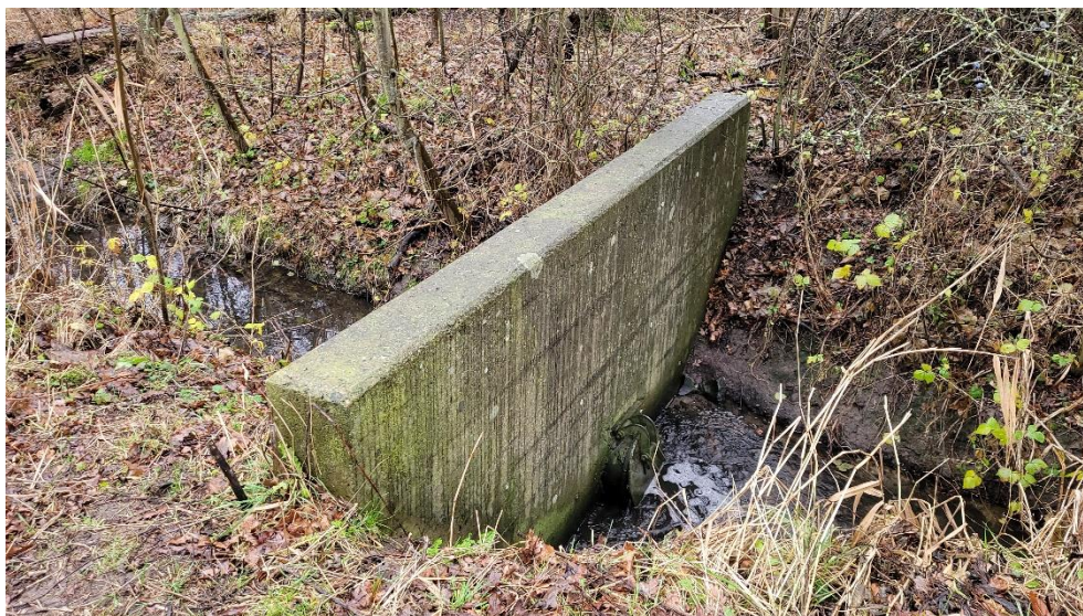
Figur 5-11 Eksempel på bygværk der krydser vandløb. I dette eksempel er der en passiv højvandsklap på søværts side.
