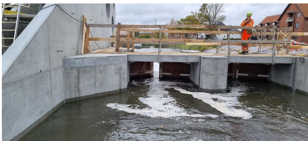
Figur 5-5 Bygværket er udstyret med sidehængte hydrauliske sluseporte som lukkes ved stormflod.
