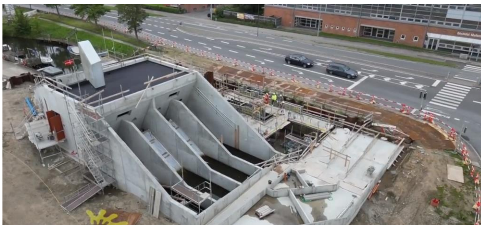
Figur 5-3 Det næsten færdige bygværk i Aabenraa. Bygværket kan løfte ca. 9 m 3 /sec
