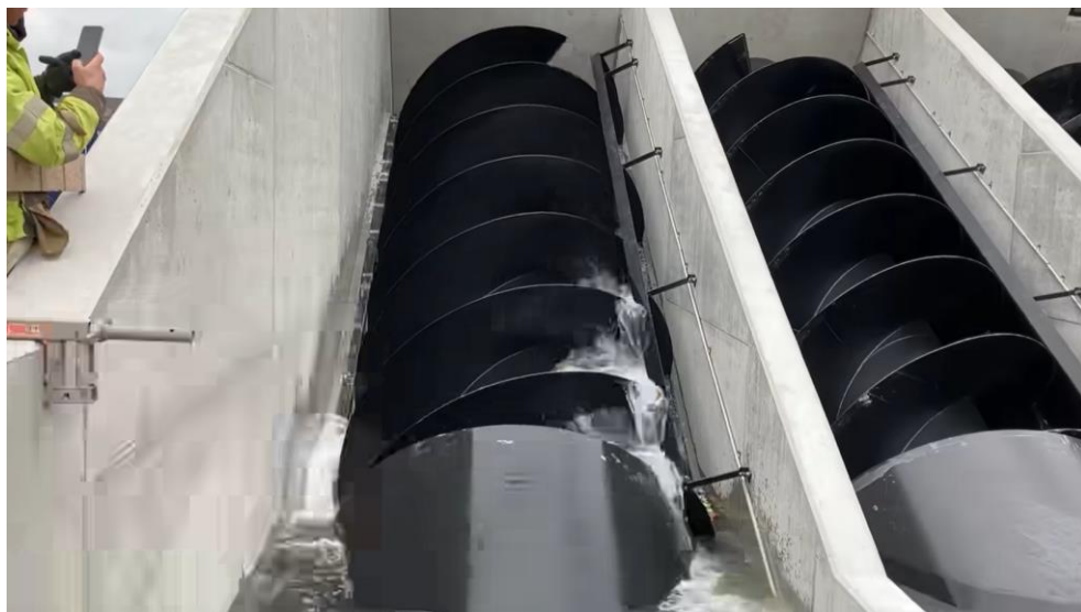
Figur 5-4 Snekkerne er et simpelt løfteprincip som til forskel fra skaktpumper ikke slår fiskene ihjel og dermed ikke kræver et driftstungt stort bygværk for at overholde afgitringskrav på 6x6 mm.
