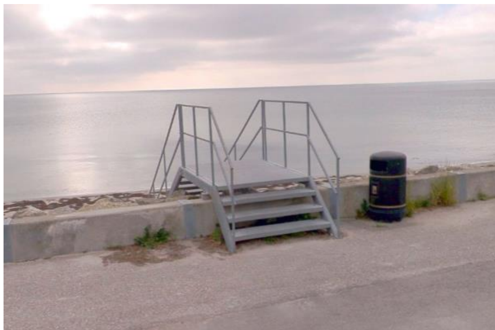
Figur 6-3 Trappe over højvandsmur.
