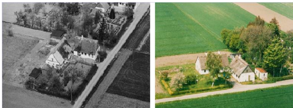
Figur 1: Viser luftfotos af Huslodderne 12 fra henholdsvis 1949 og 1988 1
