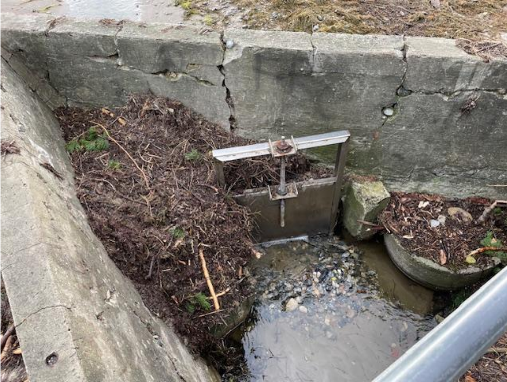
Figur 11 Højvandslukket, foto vinteren 2023/24 (foto OJJ)
