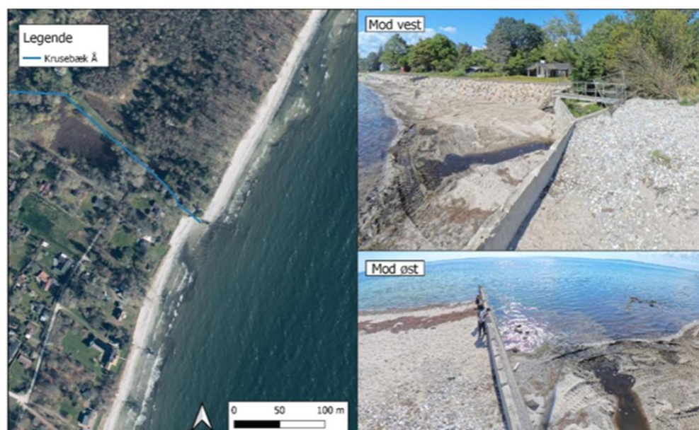
Figur 3 COWI's rapport vedr. Betonhøfden lige nord for Krusebækken
