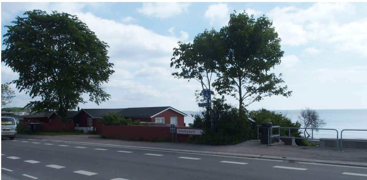
Figur 2-9 Eksisterende mur-passage syd for Strandhusene bør bevares uændret som ende-fæste for en spuns øst om Strandhusene. Øverste trin og vejmidte er her beliggende ca. 5 cm højere end sikringsniveauet i kote 3,0.
