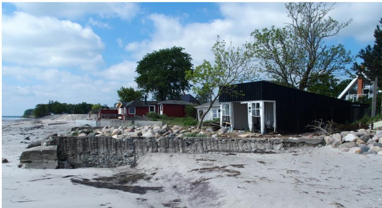
Figur 2-12 Nuværende højvandsmur langs Strandhusene 4 (sort bygning). De oplagte kampesten kan genanvendes til at beskytte en kommende højvandsmurs nedre yderside, svarende til mur-strækningerne nord for åen.
