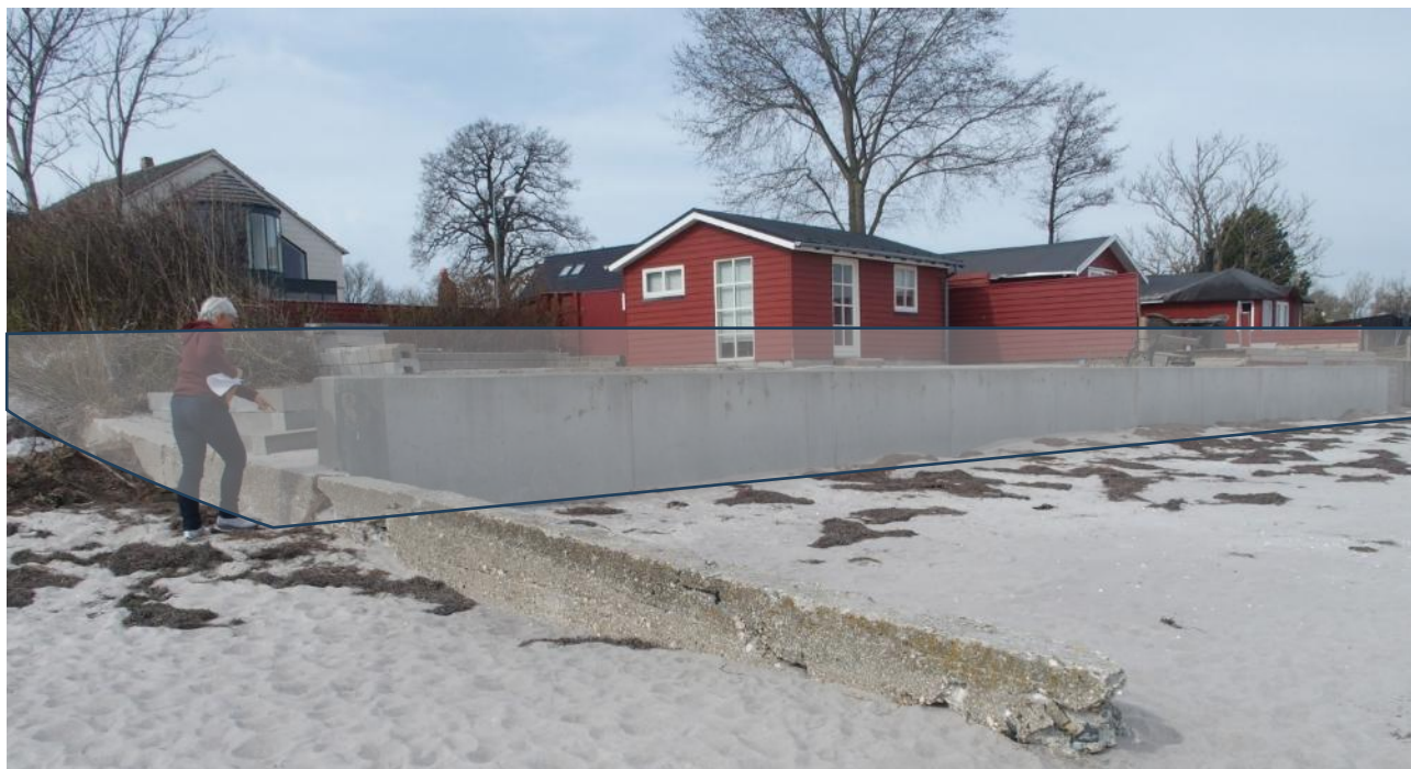
Figur 5-4 Eksisterende mur langs Strandhusene 7 og 8 kan udnyttes som fundament for den nye højvandsmur. Murens placering er antydnet med transparent figur. Den gamle betonmur nederst i billedet nedbrydes.
