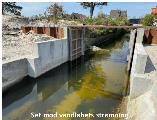
Figur 4-17 Sluse under udførelse ved udløbet fra Solrød Bæk er udført med sidehængte porte under etablering - sluse fra Wintec, foto fra HedeDanmark.
