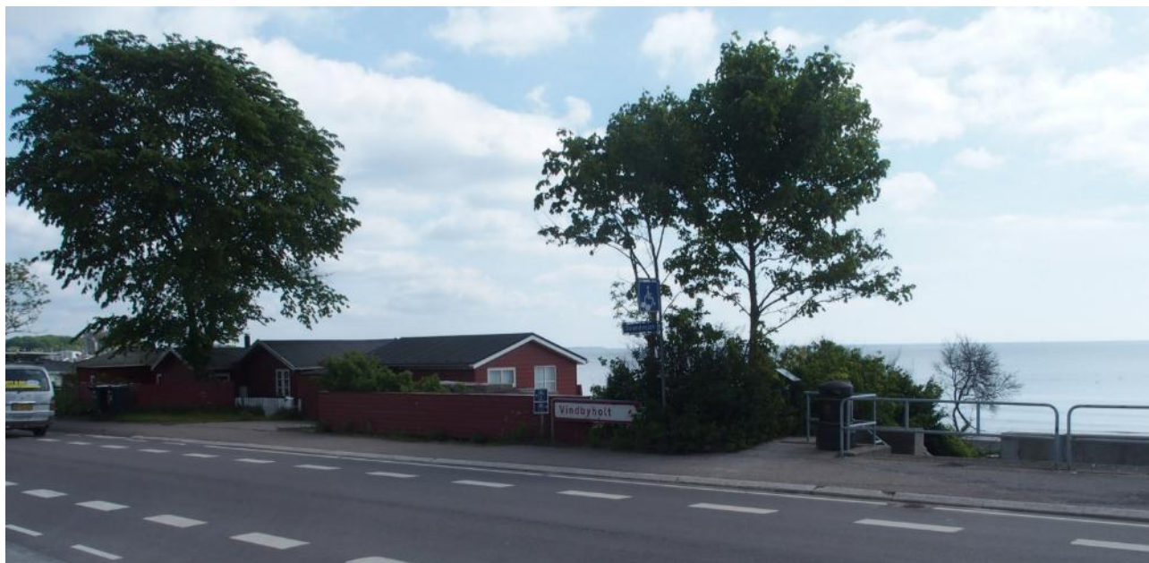
Figur 5-7 Eksisterende mur-passage syd for Strandhusene bør bevares uændret som ende-fæste for en højvandsmur øst om Strandhusene. Øverste trin og vejmidte er her beliggende ca. 5 cm højere end sikringsniveauet i kote 3,0.
