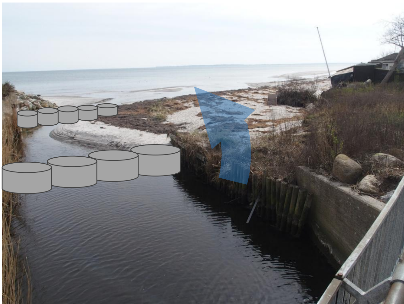
Figur 4-21 Faxe Å omlægges midlertidigt (blå pil) og byggegrube etableres i det nuværende vandløbsprofil mellem to afspærringer (grå cylinder-rækker).
