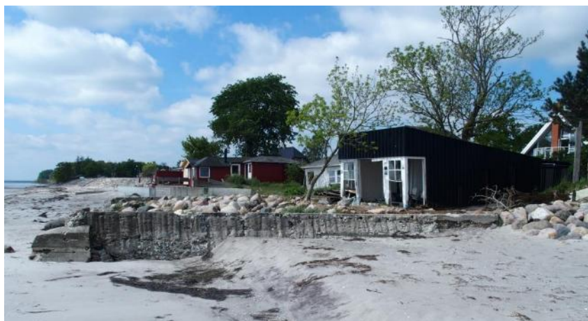
Figur 5-2 Nuværende højvandsmur langs Strandhusene 4. Muren nedbrydes, kampesten genanvendes som ydre/havværts stenkastning til at beskytte en kommende højvandsmurs nedre yderside, svarende til murstrækningerne nord for åen.
