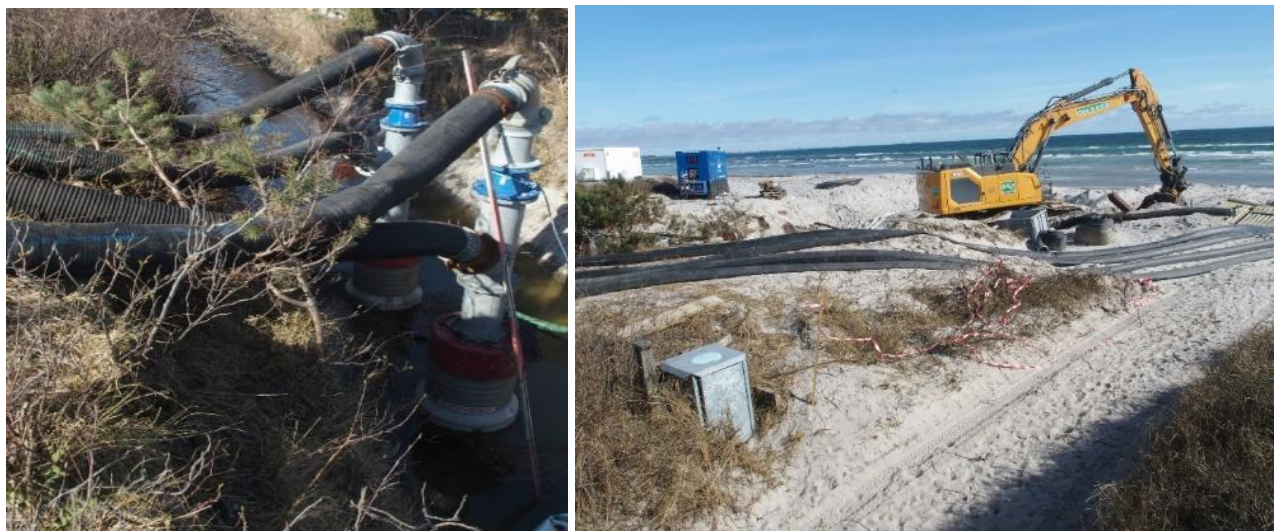
Figur 4-5 Mobile dykpumper kræver mobil generator.
