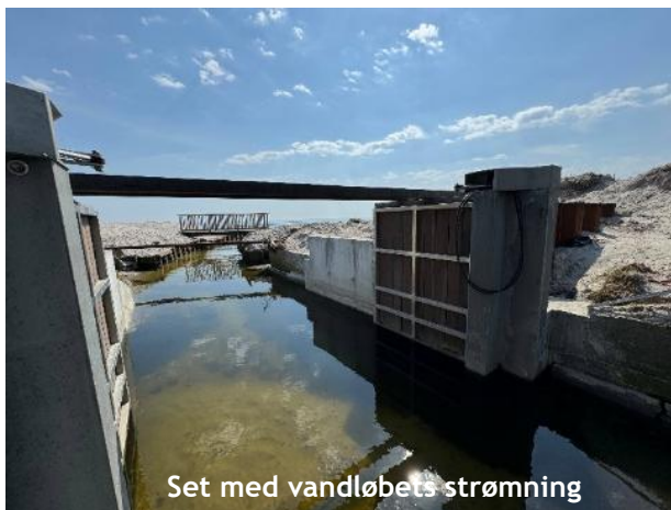
Figur 4-17 Sluse under udførelse ved udløbet fra Solrød Bæk er udført med sidehængte porte under etablering - sluse fra Wintec, foto fra HedeDanmark.
