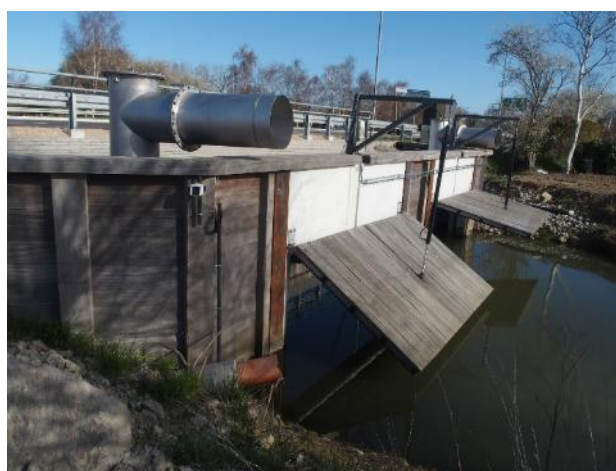
Figur 4-8 Fastmonterede bagvandspumper fra Xylem, 2 * 1000 l/s - tophængt sluse fra Wintec ved Skensved Å.
