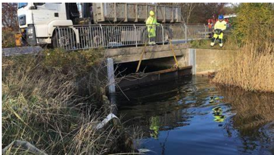
Figur 4-9 Eksisterende afspærring på Faxe Å med stålblader. Fra Faxe Kommune.
