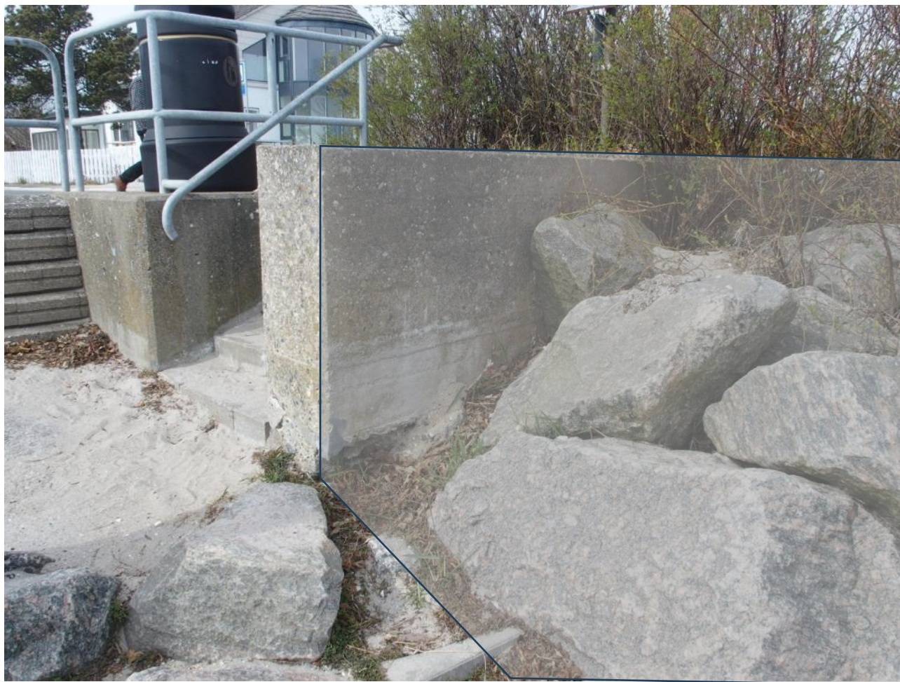
Figur 5-6 Den nye in-situ støbte højvandsmur afsluttes tæt mod muren langs sydsiden af nedgangstrappen. Murens placering er antydnet med transparent figur.
