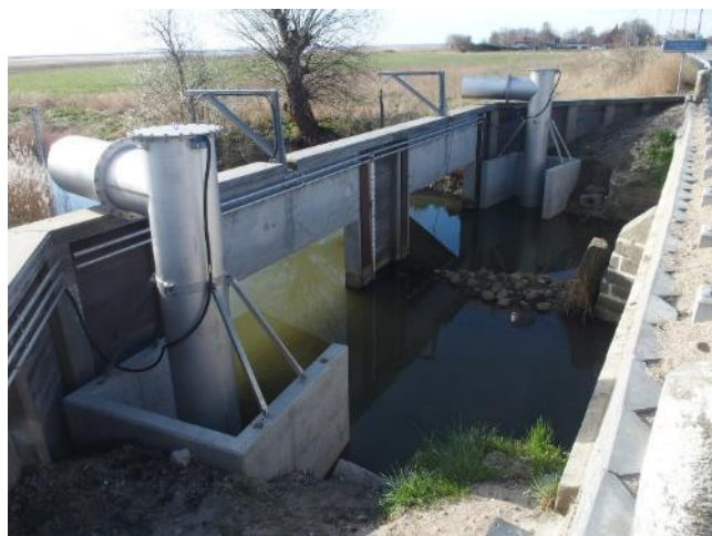
Figur 4-8 Fastmonterede bagvandspumper fra Xylem, 2 * 1000 l/s - tophængt sluse fra Wintec ved Skensved Å.
