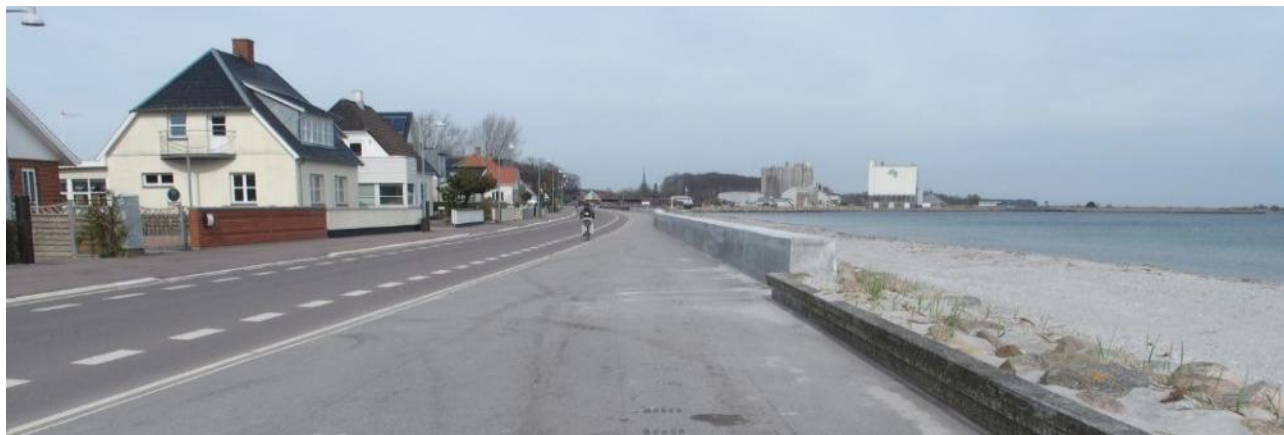
Figur 3-1 Sydlig ende af den reparerede højvandsmur.
