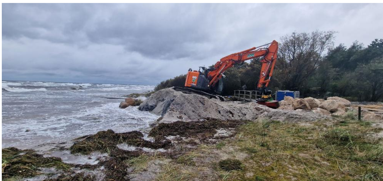
Figur 4-6 Oktober 2023. Beredskabssituation med afspærring af vandløb uden sluse med samtidig opstilling af mobile pumper til bagvandshåndtering. Foto: HedeDanmark.
