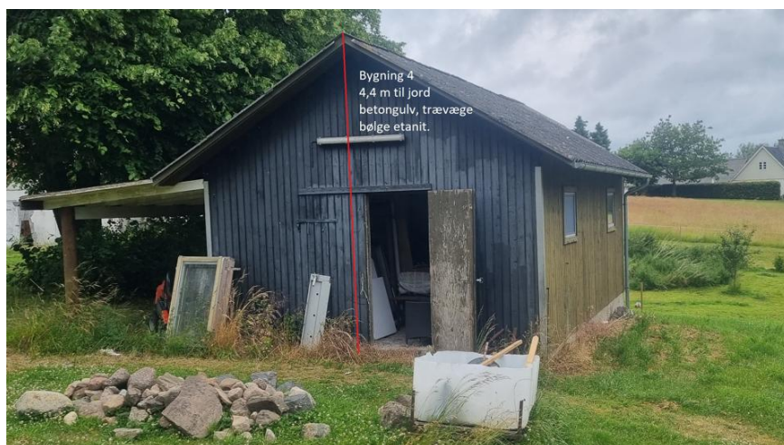
Figur 4: Figuren viser bygning 4 og overdækning.
