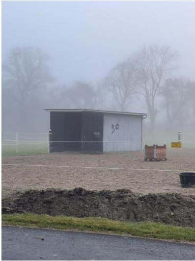
Figur 2: Billedet viser facade på læskur
