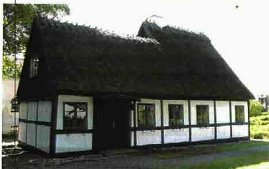
Det opdelte bindingsværkshus fra havesiden med 4 sydlige fag i 3 fags dybde og 3 nordlige fag i 4 fags dybde. Foto maj 2007
