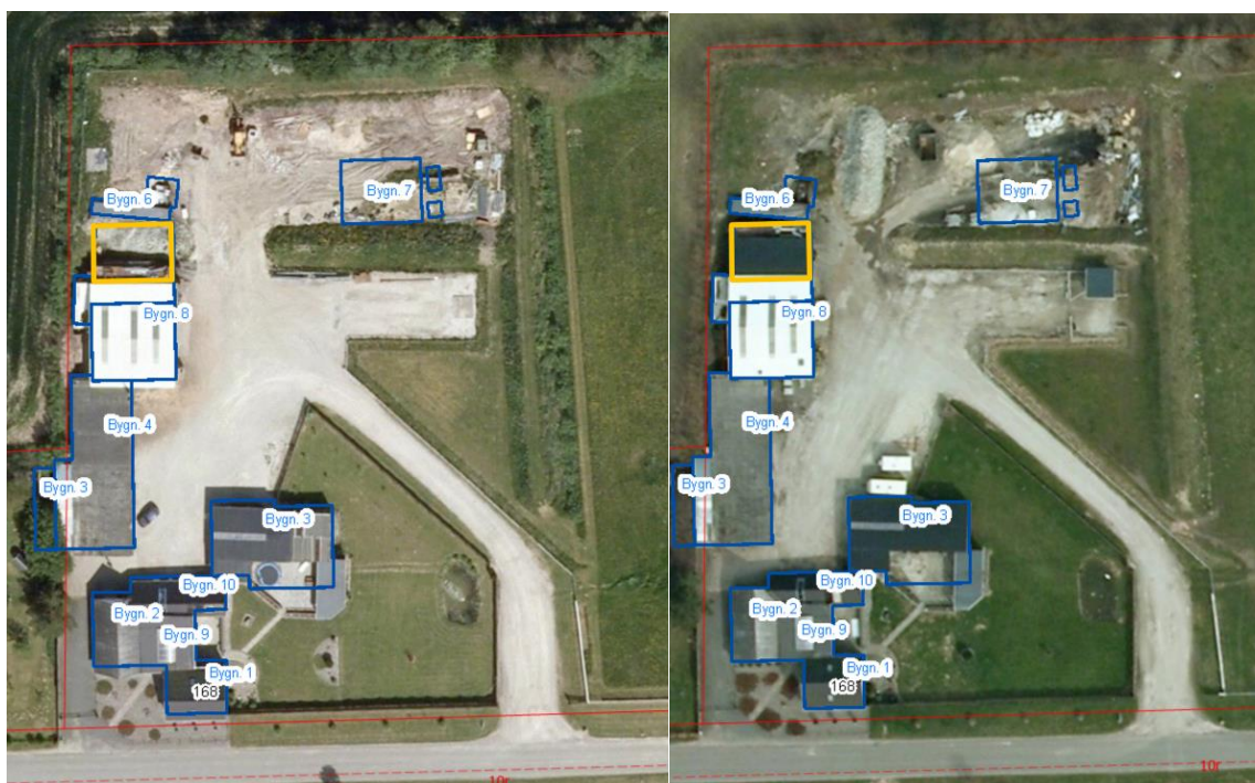
2008 og 2010 – tilbygning på bygning 8
