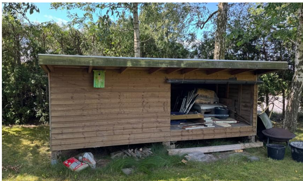
Figur 2: Viser udseende af shelteret.
