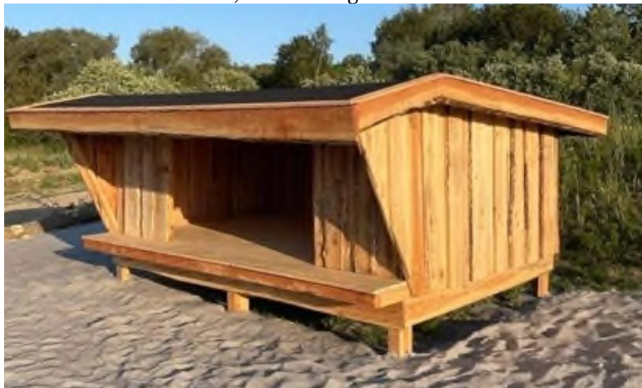
Figur 2: Billede af den shelter model der er opført på adressen
