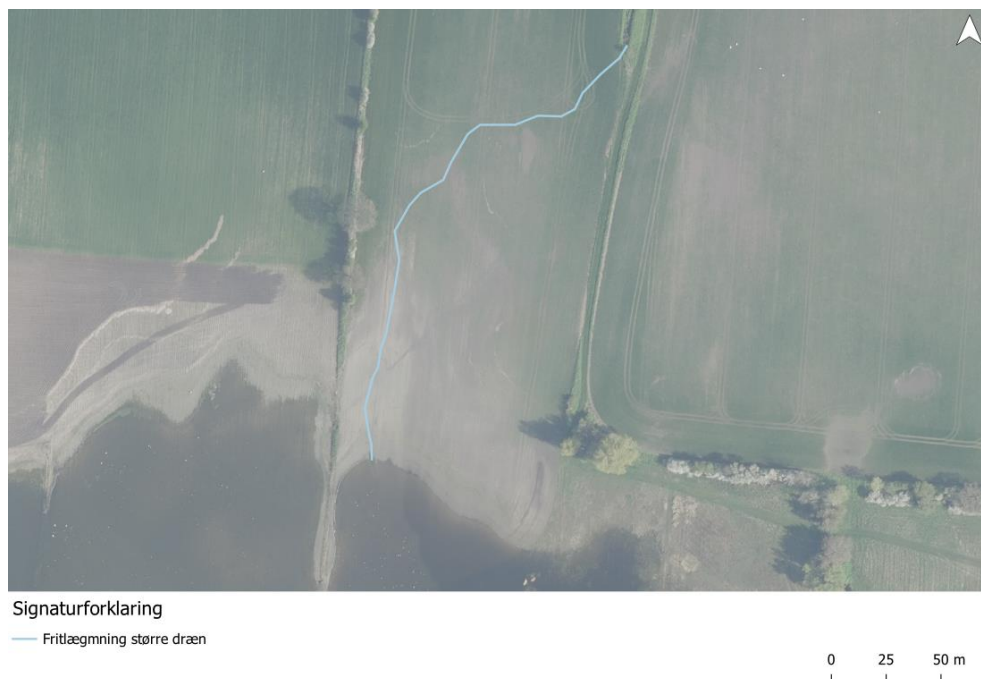
Figur 3-17 Fritlægning af det større dræn fra nord.
