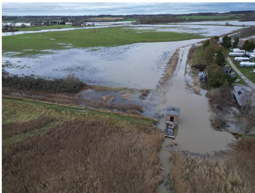
Figur 2-3 Pumpehuset med Sivet og Grønnemose i baggrunden i dagene umiddelbart efter stormfloden 2023 (Naturstyrelsen, 2023).
