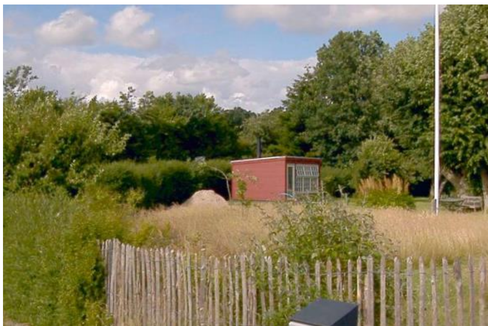
Figur 3 - Bygning efter ombygning i 2022.
