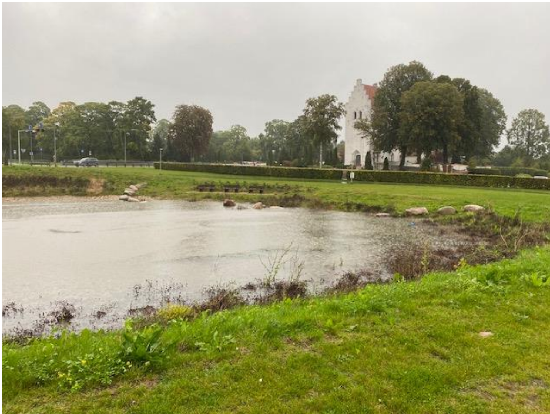
Foto af regnvandsbassin i Dalby i 2022
