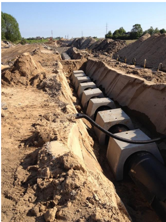
Figur 2-10 Betonryttere placeret over ledningen
