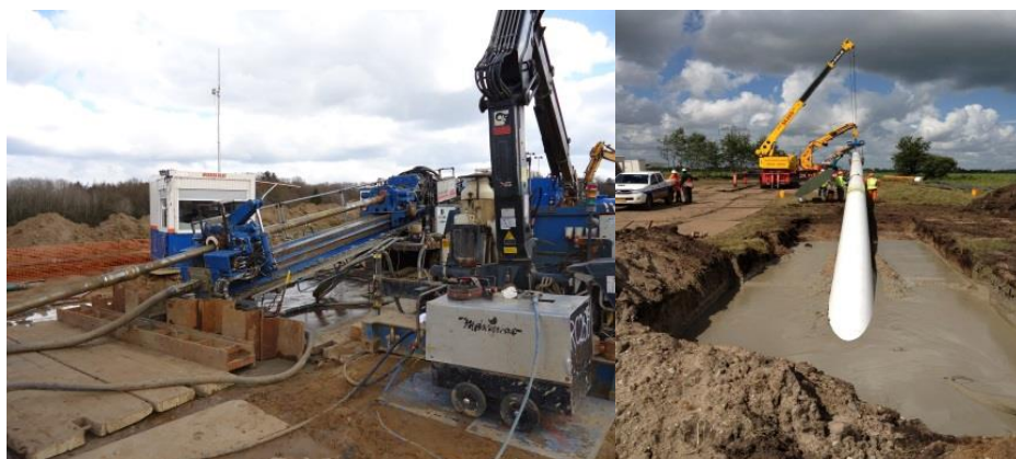
Figur 2-13 Boremaskine for styret underboring og gasrørledning under installering
