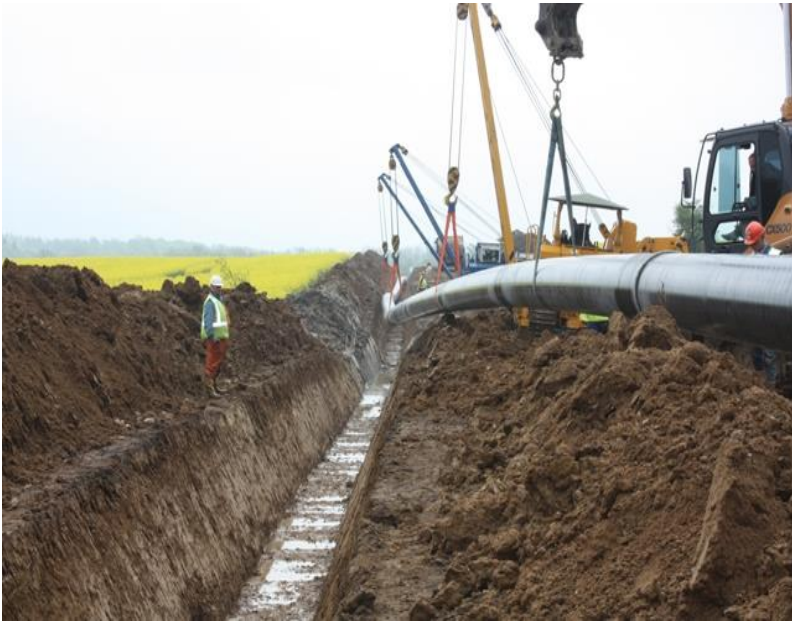
Figur 2-5 Nedlægning af gasrørledning i ledningsgrav
