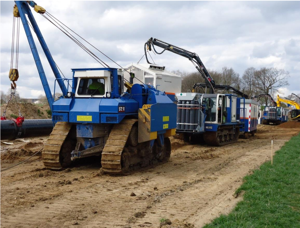
Figur 2-4 Arbejdsområde samt maskinel ved arbejde i åbent land
