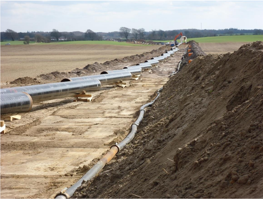
Figur 2-3 Rør udlagt i det ryddede arbejdsbælte
