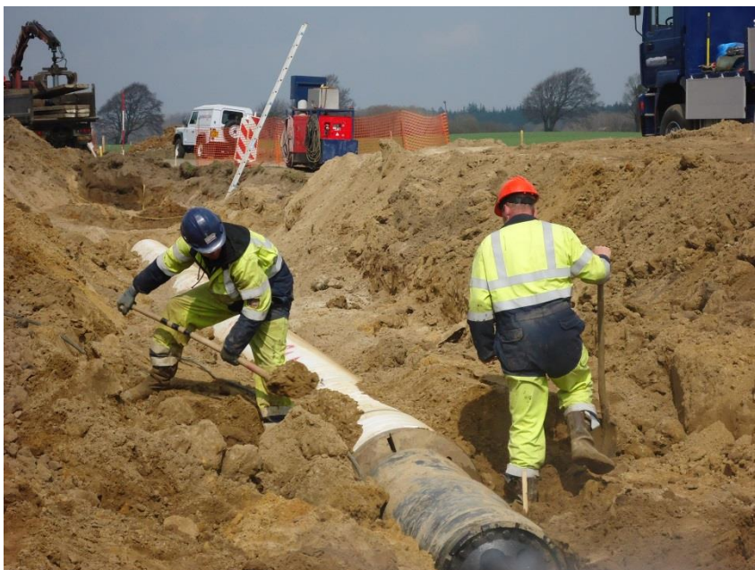
Figur 2-11 Gasrør føres under vej ved ramning
