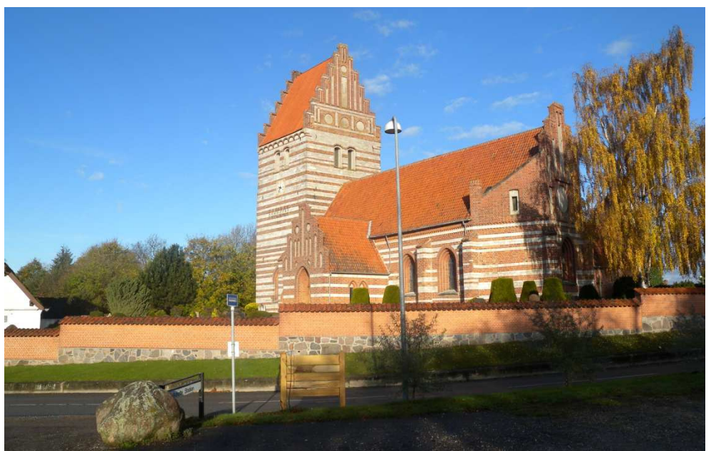
Roholte Kirke er opført med en blanding af munkesten og kalksten fra Stevns Klint.
