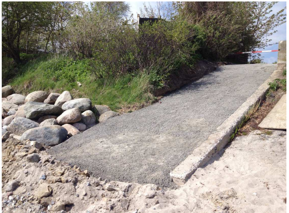
Figur A.23 Nyrenoveret nedkørselsrampe. Strandniveauet er sunket foran rampen, så der er blevet efterfyldt på stranden med en blanding af sand og sten.
