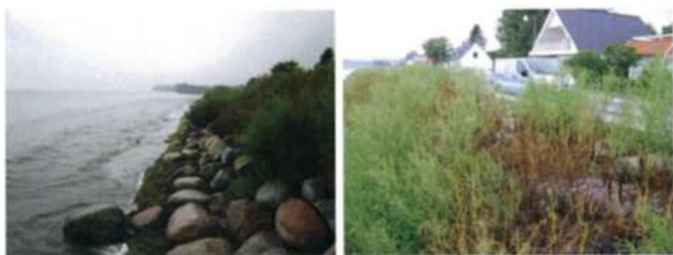
Figur 2.20 Kysten langs Strandvejen i 2008. Sandstranden er eroderet bort og der er høj strandvegetation på stenkastningen. Billede taget af Kjeld Larsen, Faxe By- og Kystlaug, fra DHI's rapport fra 2010 vedr. udvidelse af havnen Ref. /2/.
