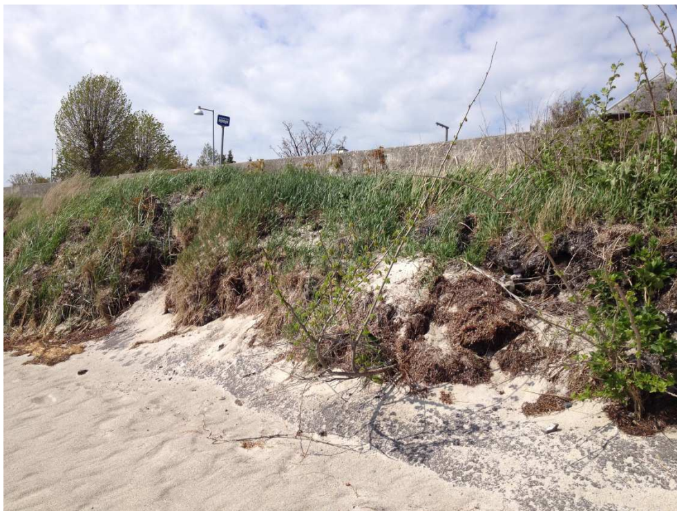
Figur A.20 Asfaltskråning med jord og bevoksning ovenpå.
