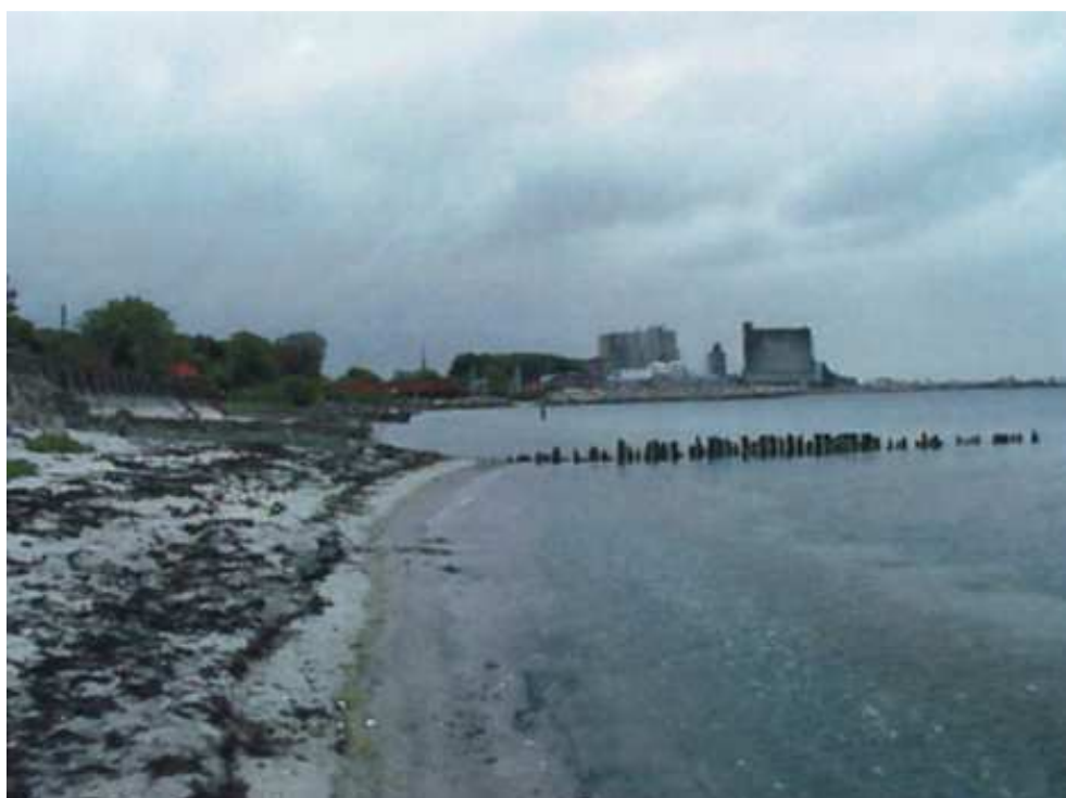
Figur 2.9 Stranden sydvest for havnen i 2001 med nedbrudte hofder uden virkning.
