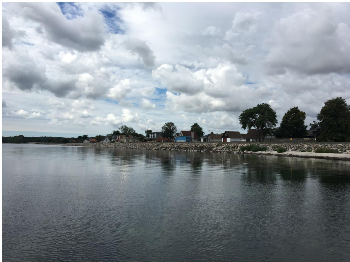
Figur 1-1: Kyststrækningen ved Faxe Ladeplads med stenkastning (16.08.2016)
