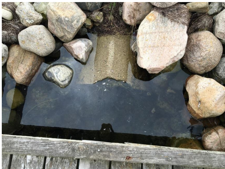
Figur 4-9: Vandudskiftningsrør mellem lystbådehavnen og åben hav
