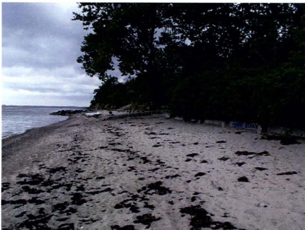
Stranden nordøst for Delhoved, hvor klinten er fastholdt med stenhøfder. Der ses en bådrampe i forgrunden.
