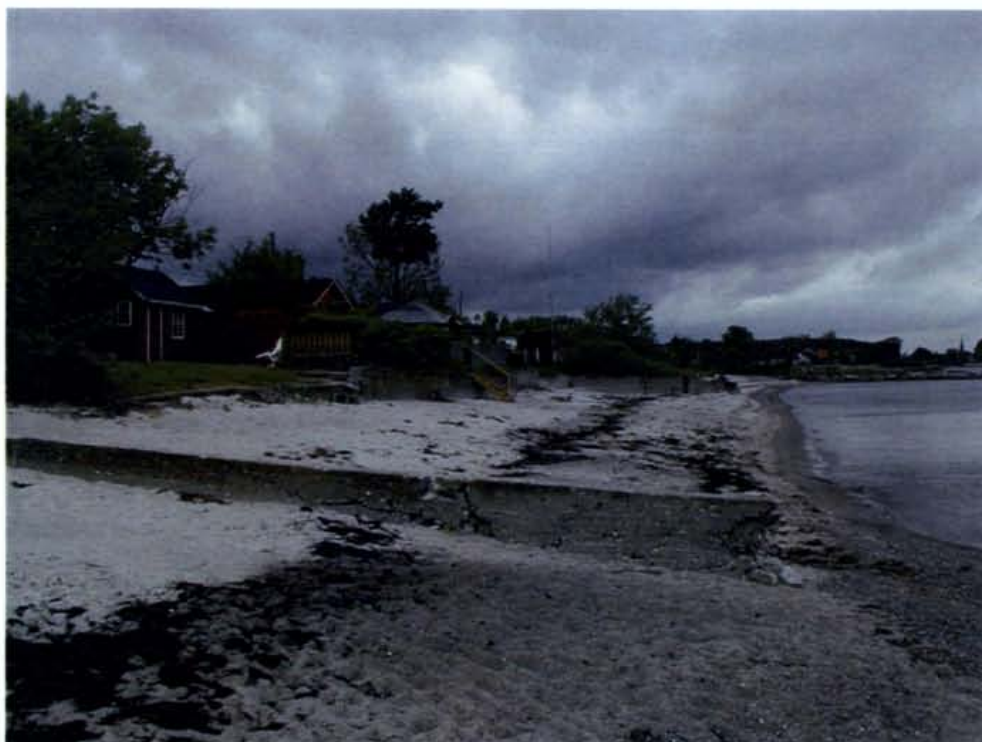
Foto 25: Stranden sydvest for Fakse Å ud for Rosendal Gods' sommerhuse. Der ses et fremspring i beton støttemuren og en nedbrudt hofde. Foto taget mod nordøst.
