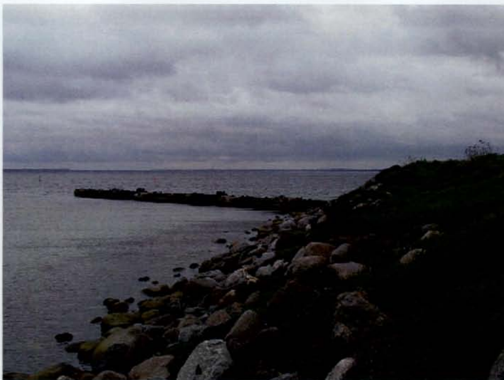
Sandfangsmole af betonpramme. Foto taget mod syd.
