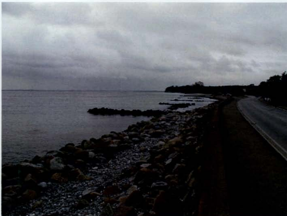
Stranden sydvest for havnen hvor der er udlagt en stenrække til beskyttelse af muren.
