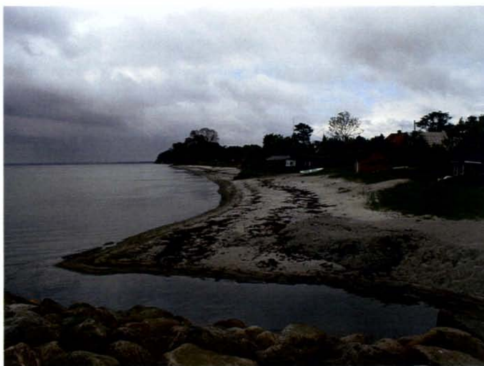
Foto 24: Fakse Å's udløb. Der ses lidt læsideerosion på grund af ledeværket. Foto taget mod sydvest.
