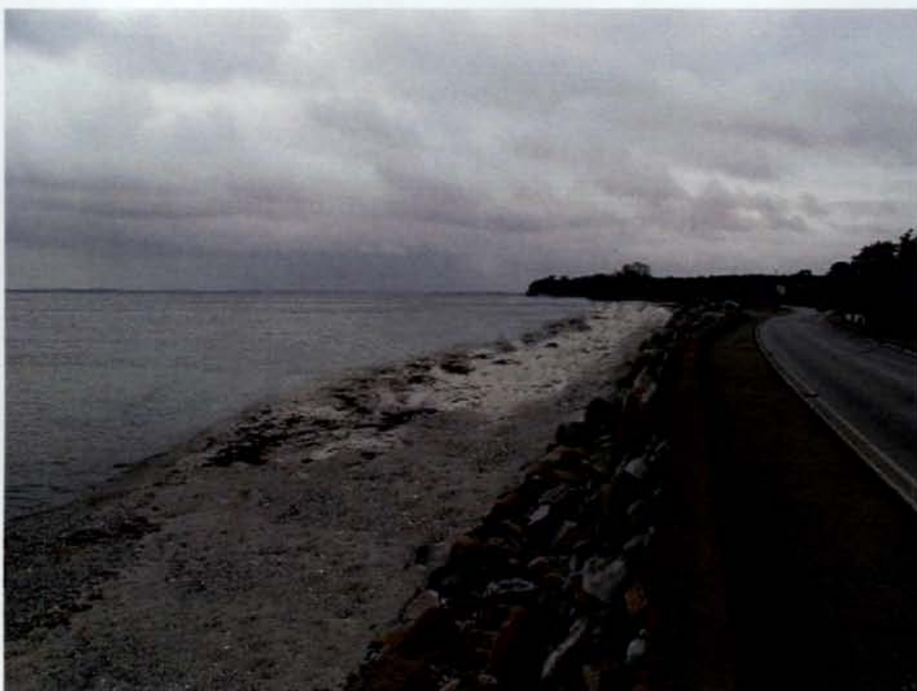
Forslag A: Stenkastning foran mur og etablering af strand ved strandfodring.
