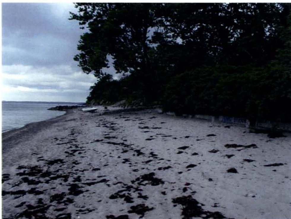
Foto 32: Stranden nordøst for Delhoved hvor klinten er fastholdt med stenhøfder. Der ses en bådrampe af beton i forgrunden.
