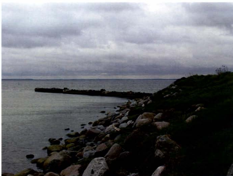
Foto 8: Sandfangsmole af betonpramme. Foto taget mod syd.
