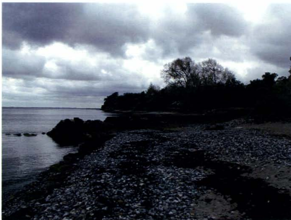
Foto 29: Høfden ved den lille kanal, Kruse Bæk. Der ses mange sten på stranden. Foto taget mod sydvest.
