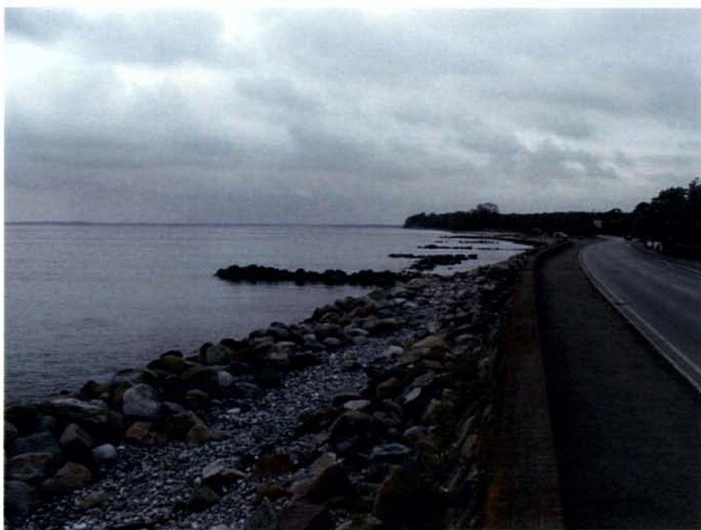
Foto 18: Stranden sydvest for havnen hvor der er udlagt en stenr kke til beskyttelse af muren. Foto taget mod sydvest.
