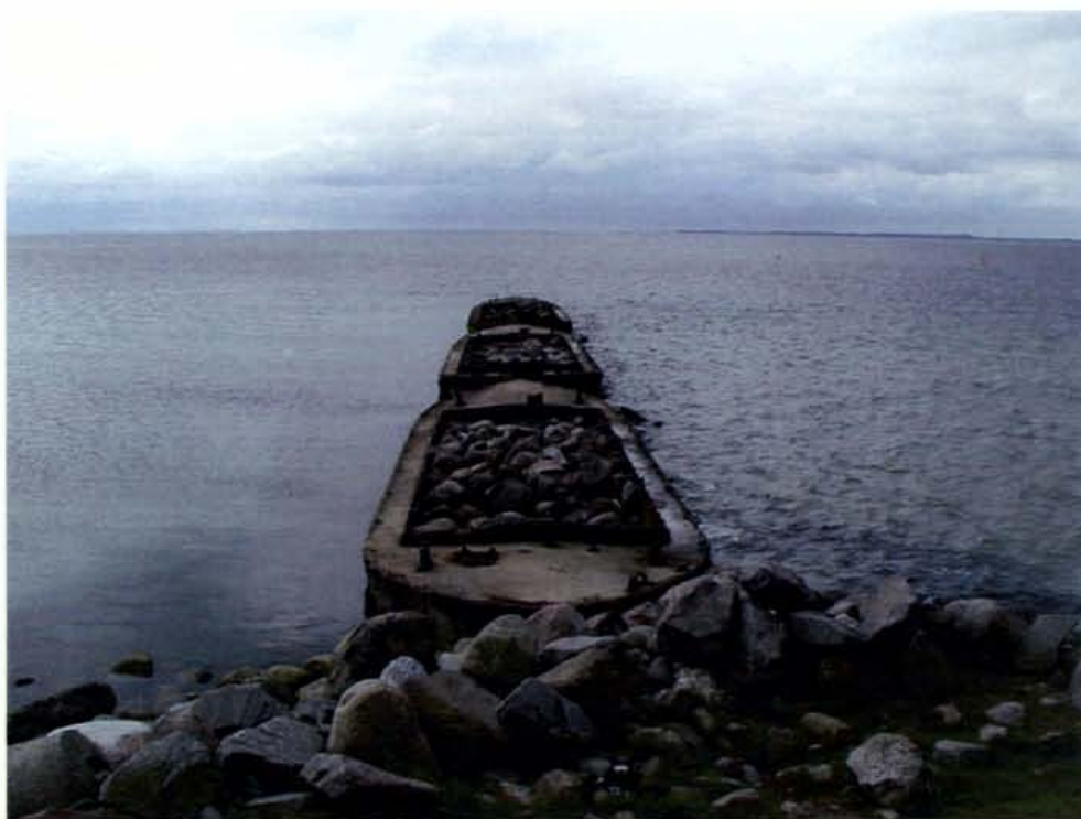
Foto 9: Betonprammene til beskyttelse af havneindsejlingen mod tilsanding.
