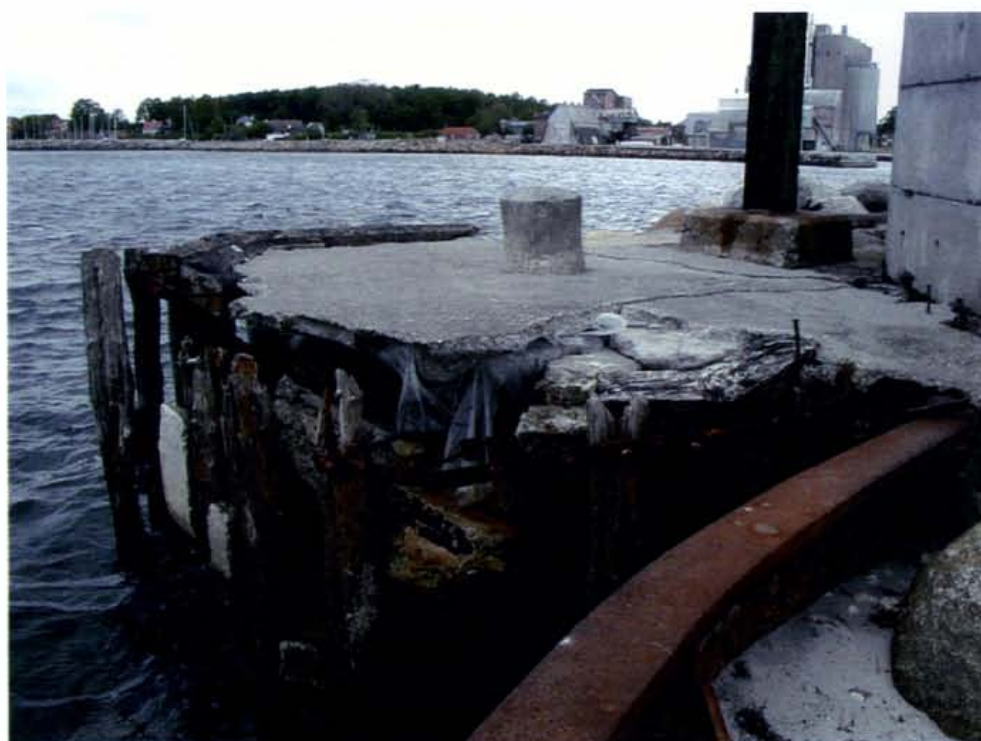
Foto 10: Forfalden anløbskaj på sydsiden af havneopfyldningen ud til sejlerenden. Foto taget mod sydvest.
