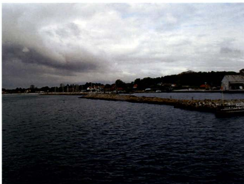
Foto 12: Stenkastningsmolen der beskytter havnebassinet og lystbådehavnen. Foto taget mod sydvest.
