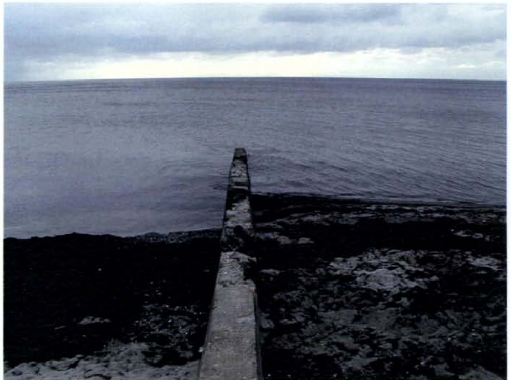
Foto 19: Nedbrudt h fde umiddelbart sydvest for havnen. H fden fanger dog lidt sand - fra sydvest.
