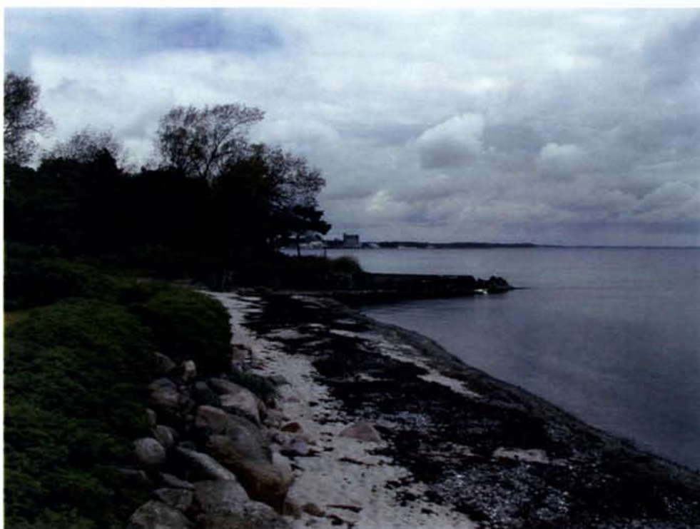
Foto 30: Stranden umiddelbart sydvest for kanalen. Læsideerosion på grund af høfden ses tydeligt.
