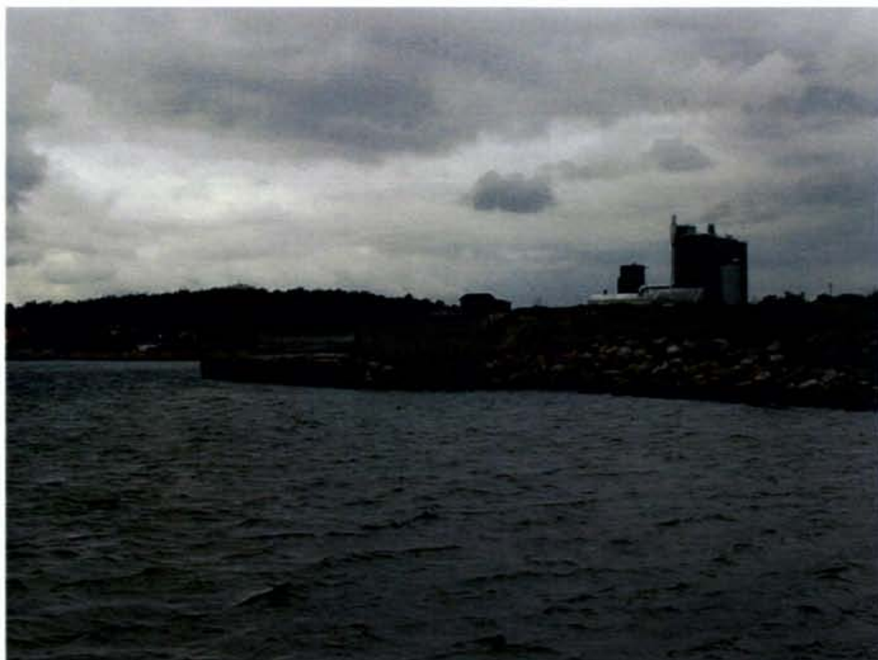
Foto 11: Den forfaldne anløbskaj set fra sandfangsmolen.
