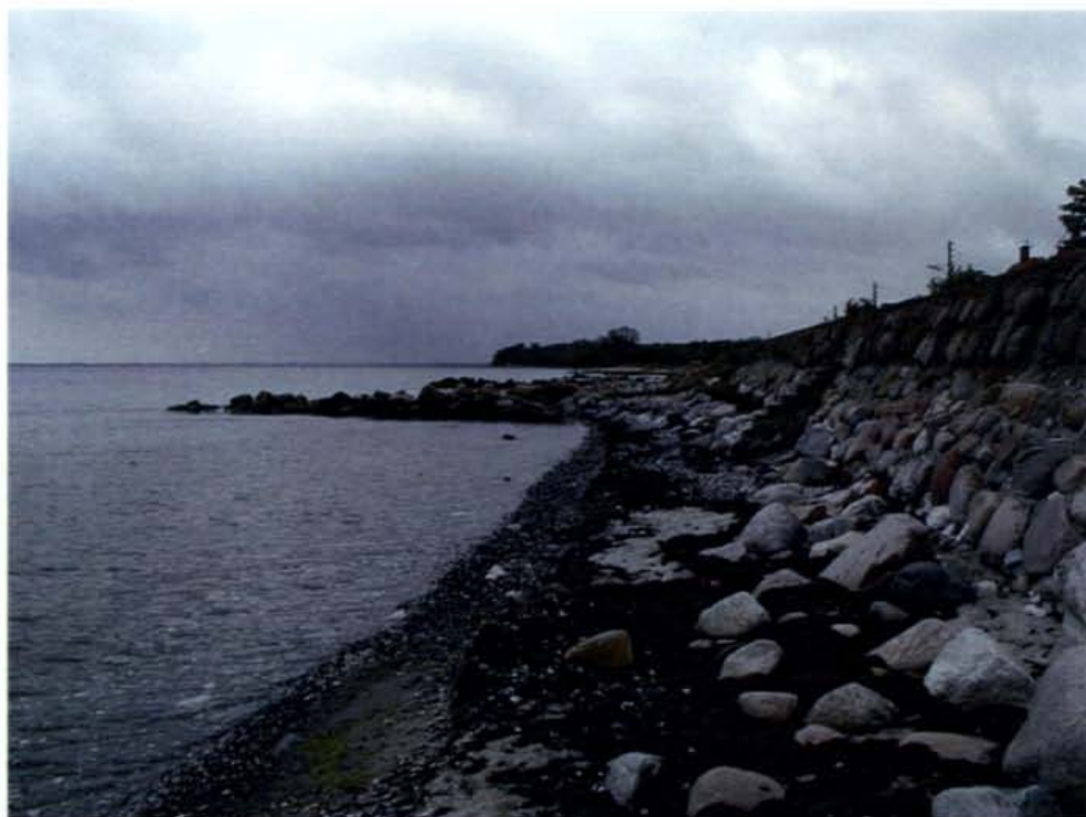
Foto 15: Stranden sydvest for havnen hvor al sandet er borteroderet. Foto taget mod sydvest.
