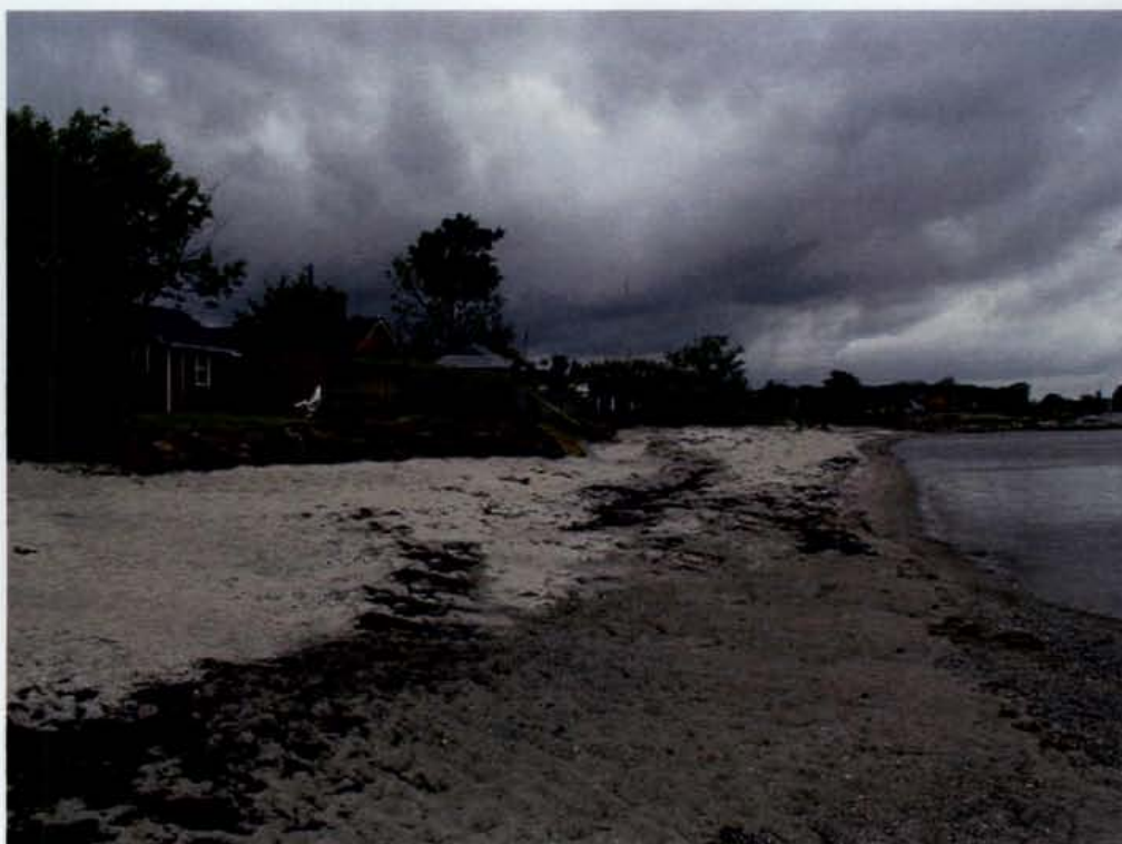
Forslag A, B1 og B2: Renovering af strand, fremspring fjernet samt stenkastning foran sommerhus.
