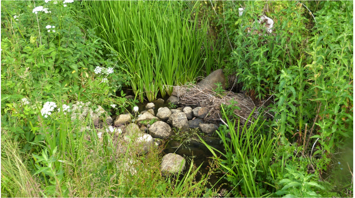
Figur 27. St. 1350. Store udlagte sten, kan risikere at virke som spærring for fisk.
