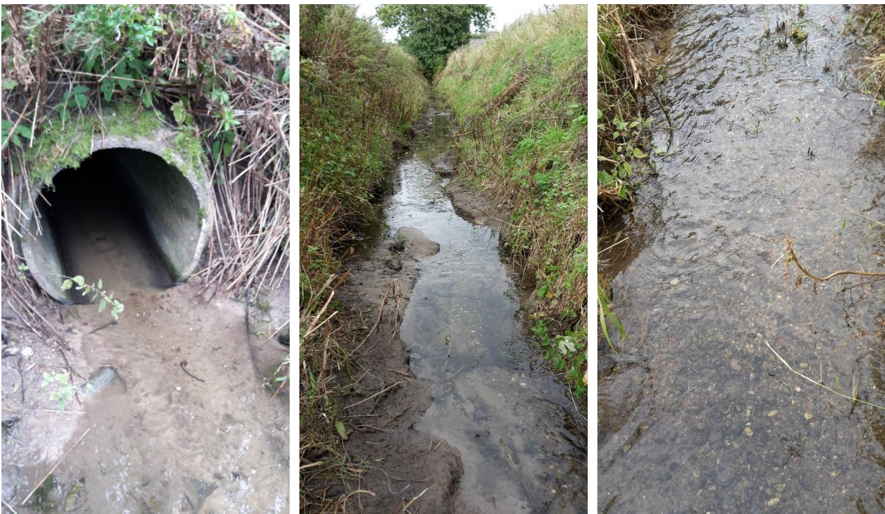
Foto 1: St.3258, Pebringe Bæk. Rørdøb i Pebringe Bæk ved Dalbyvej. Foto 2 og 3: st. ca. st. 3300- 3400, Pebringe Bæk. Vandløbet ligger dybt nedskåret i et smalt forløb. Ved lave vandstande er der intern meandering. Bunden er variabel med både sandet, blød bund og fast bund med sten. På foto 2 ses gydebanke tæt på rørdløbet. Enkelte træer giver skyggevirksomhed.
