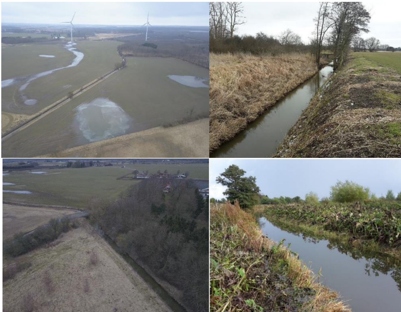
Figur 4. Nedre Stenkildebæk. Foto 1 (øverst tv): St. 2068-2900, foto er taget opstrøms. Foto 2 (øverst th.): St. 2520, foto er taget nedstrøms. Vandløbet ligger forholdsvis dybt i terræn, og med marker nært ved. Vandløbet bærer præg af næringsstofpåvirkning, og bunden er generelt blød. Foto 3 (nederst tv): St. 0, foto er taget opstrøms. Sandfanget kan anes umiddelbart efter broen. Foto 4 (nederst th): st. 1500, foto er taget opstrøms. Massive forekomster af Rød hestehov dominerer vandløbets brinker. Om vinteren er brinkerne blottede og udsat for erosion.
