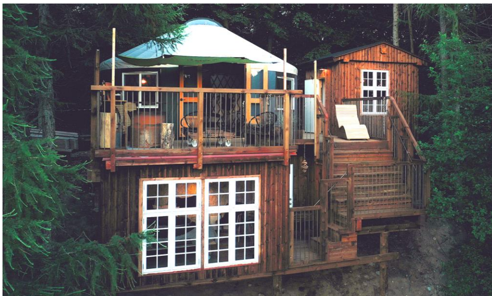
Figur 1 – Viser "Cool Grey" platformen med glampingtelt og toiletbygning øverst og en trappe ned til et ekstra annekset nedenfor. Byggeriet er opført ud over en skrænt ned til en tidligere grusgrav, og annekset kan derfor ikke ses inde fra stien.
