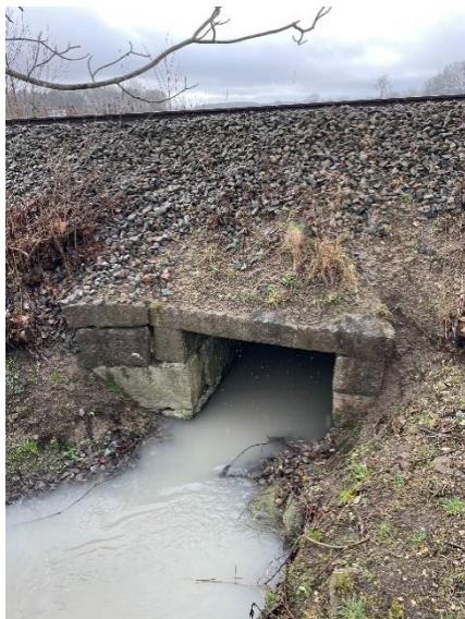
Figur 1: Udløb stenliste er en firkantet konstruktion i granit. Indløb i stenliste er en rund konstruktion i beton
