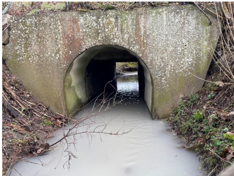
Figur 1: Udløb stenliste er en firkantet konstruktion i granit. Indløb i stenliste er en rund konstruktion i beton
